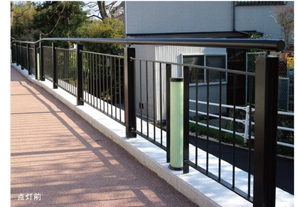
島根県松江市 玉造温泉駅 (柵:H形鋼との組合せ)
